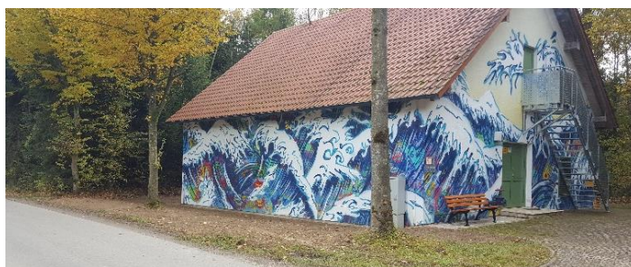
Wasserwerk von außen
