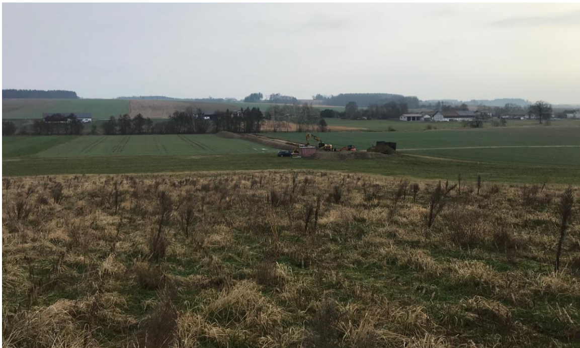
Abbildung 5: Laufende Bauarbeiten am 24.03.2025.
