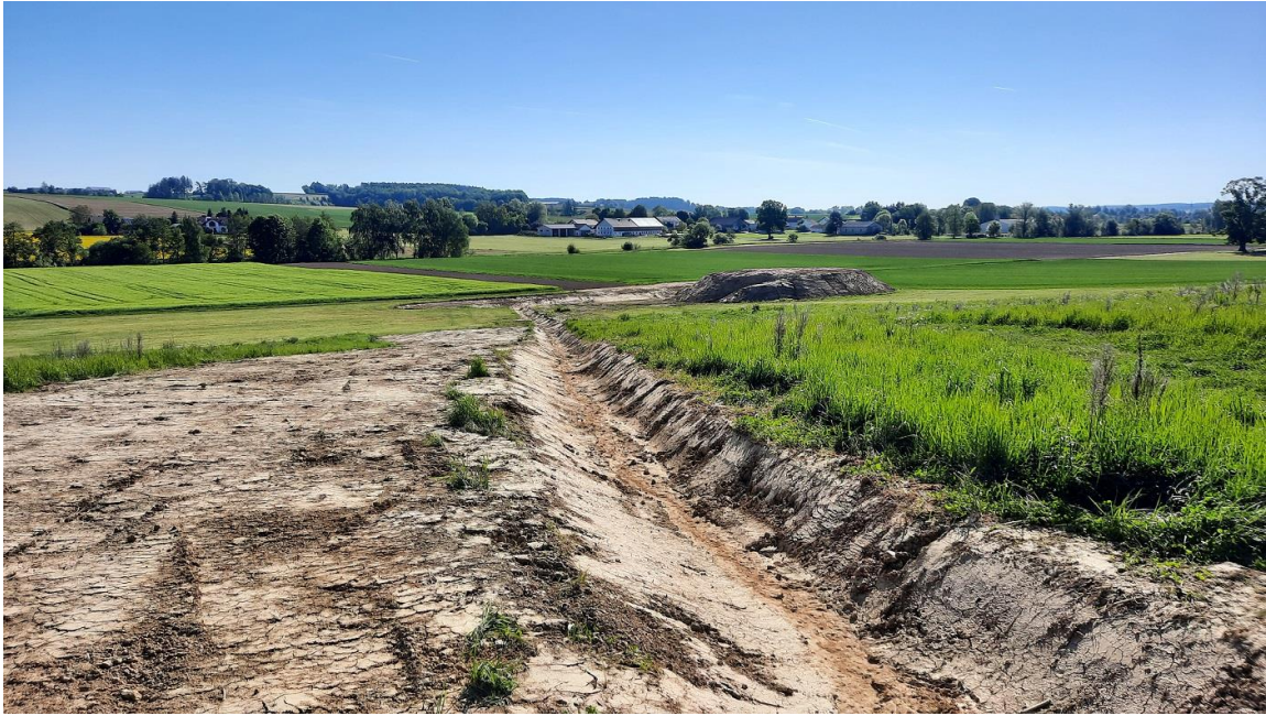
Abbildung 6: Abgeschlossene Bauarbeiten am 12.05.2025.
