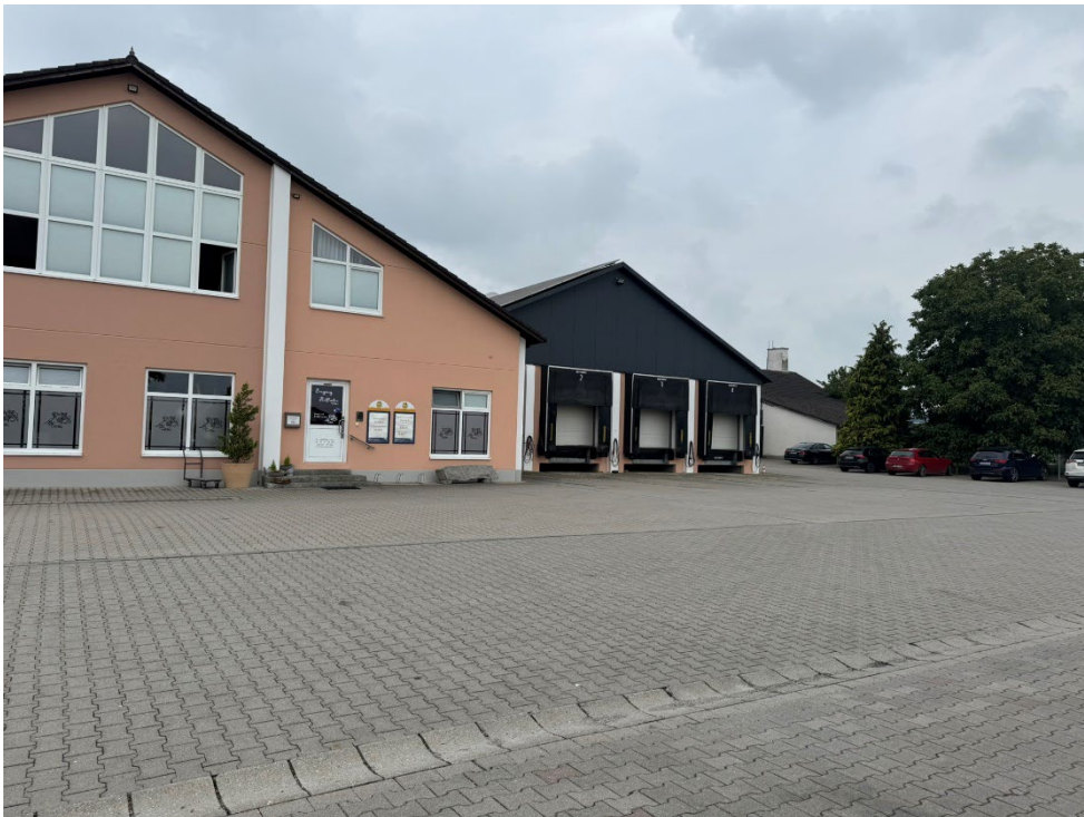
Abb. 5: Ansicht von Südosten – Verkaufsraum in Produktionshalle und Garagenanbau vor Wohnhaus, Foto TLC Landgeflügel Fr. Groß (August 2025)
