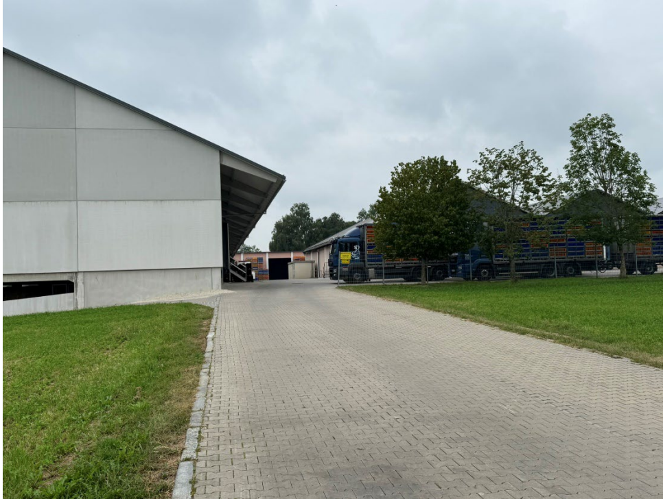
Abb. 6: Ansicht von Osten – genehmigte Produktionshallen, Foto TLC Landgeflügel Fr. Groß (August 2025)
