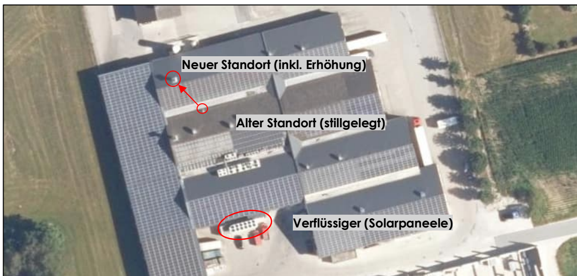
Abbildung 7: Luftbild mit Kennzeichnung der veränderten Lüftungstechnik /33/
